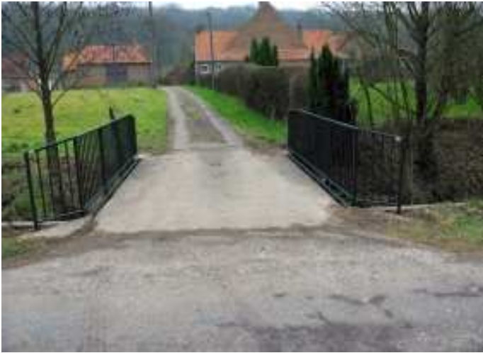
Un pont sécurisé sur la Planquette
